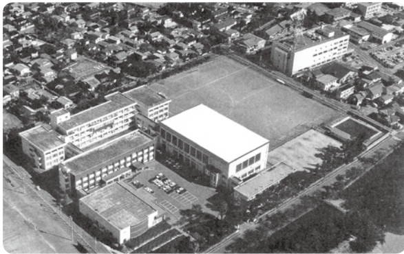
現校舎全景 (平成5年)
